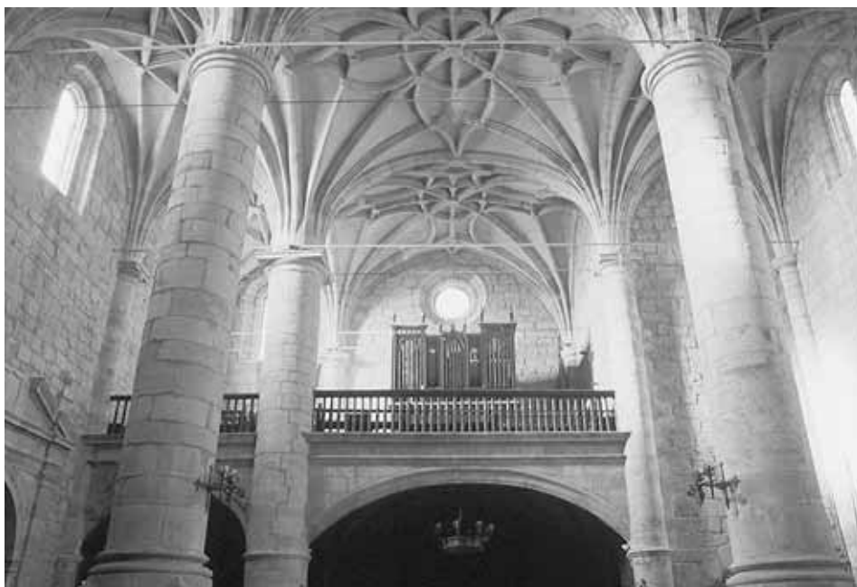
Vista interior hacia el coro alto.
