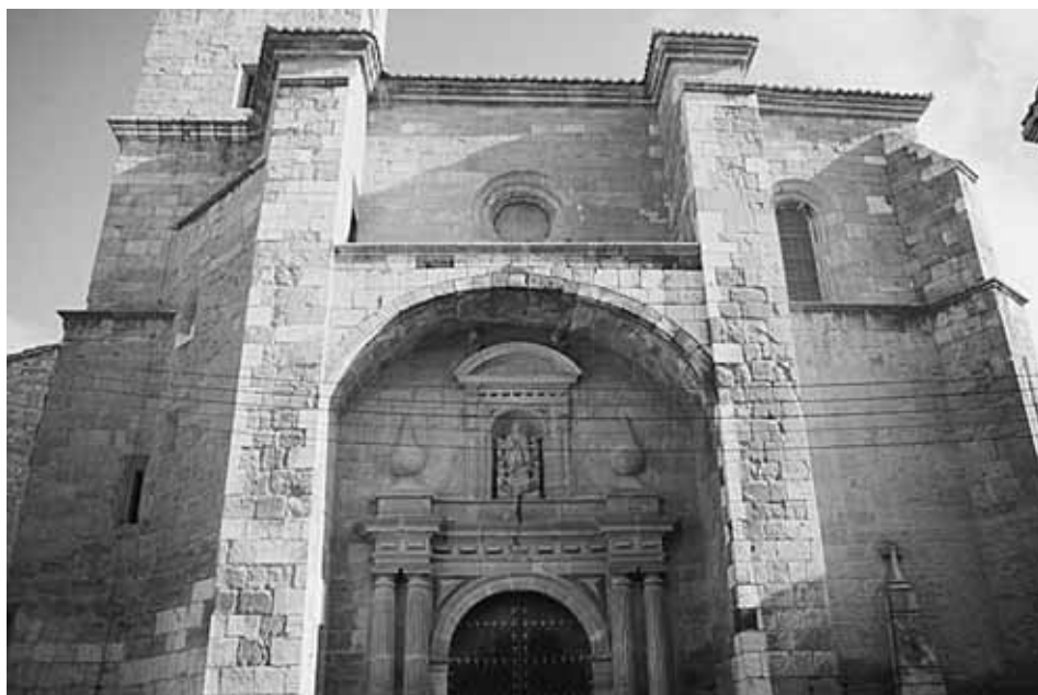
Fachada principal de Santa María la Mayor.
